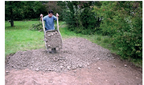
Anlage einer Ruderalfläche: Die Pflanzmulde wird mit Wandkies aufgefüllt.
