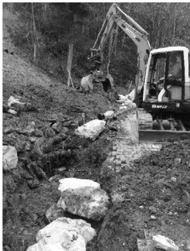
Im Kleinziel wurde mit einem Bagger eine Bachböschung mit Blocksteinen gesichert, damit die angrenzende Liegenschaft nicht mehr überflutet wird. Im Anschluss wurde das unterspülte Terrain fachgerecht aufgefüllt.
