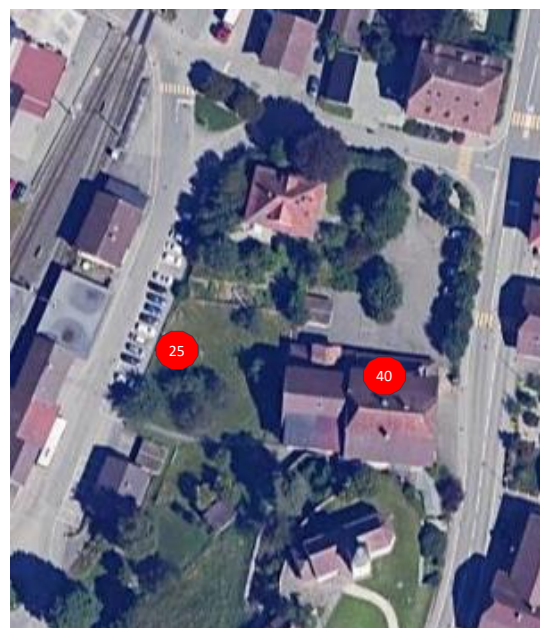
Ausbauetappe 4, Bären und Bärenmätteli mit 65kW zusätzlicher Anschlussleistung
